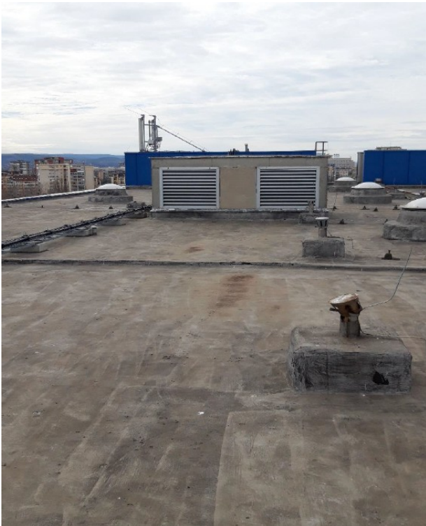
Slika 2-izgled krova, ventilacionih kapa, dilatacije
